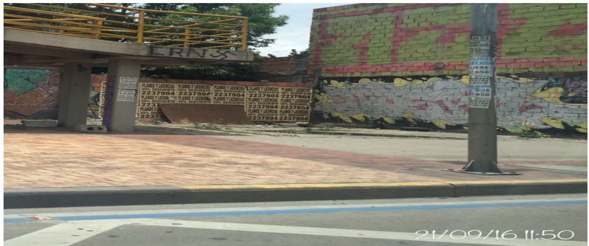
Fotografía No. 9. Elementos instalados en Espacio Público. Visita en la Localidad de Barrios Unidos, día 21 de Septiembre de 2016. No. Afiches: 14.
